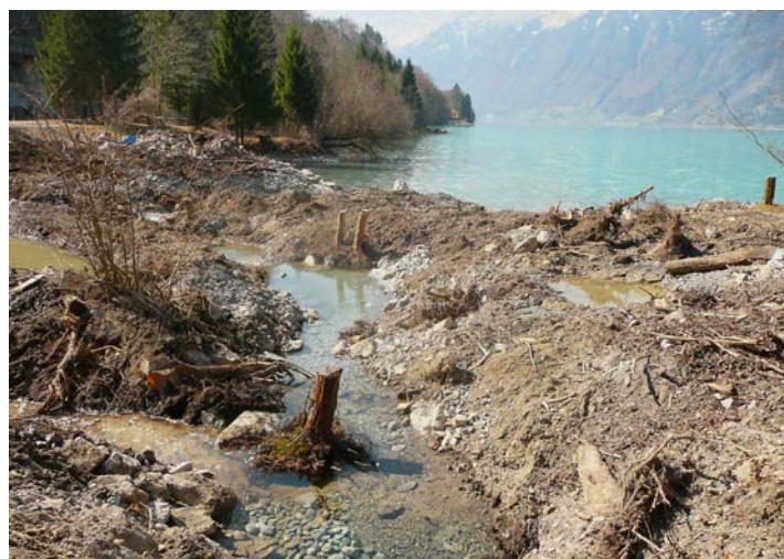
Bild 6: Die ersten Massnahmen werden bereits umgesetzt. Hier die Renaturierung der Brunnenquellen am Brienersee.
